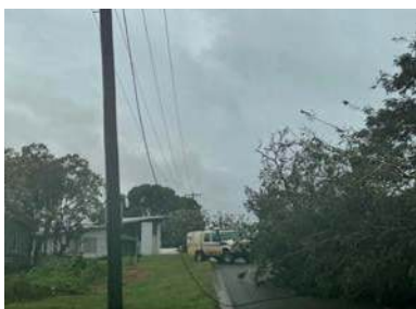
Narelle damage. Picture: SES
